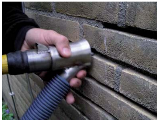
Pneumatische hakhamer met afzuiging
