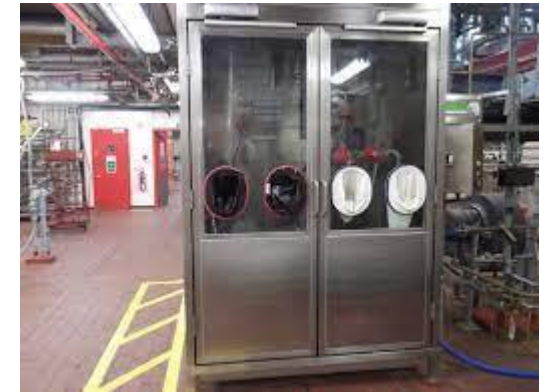
Afvulstelsel met glovebox en afzuiging
