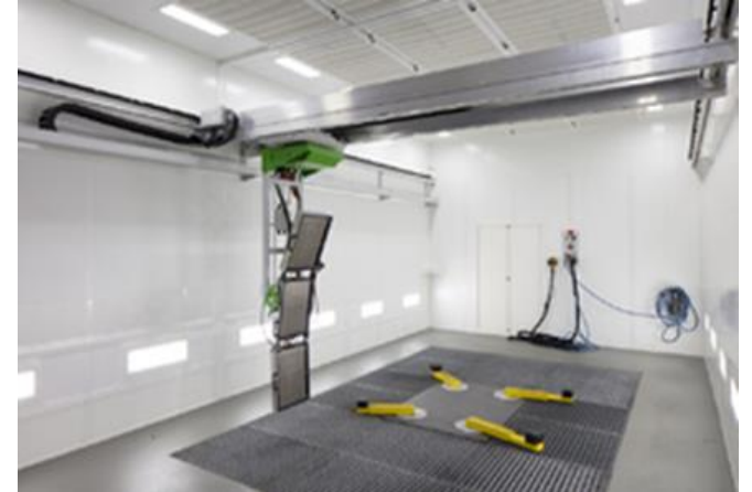
Spuitcabine met vloerafzuiging
