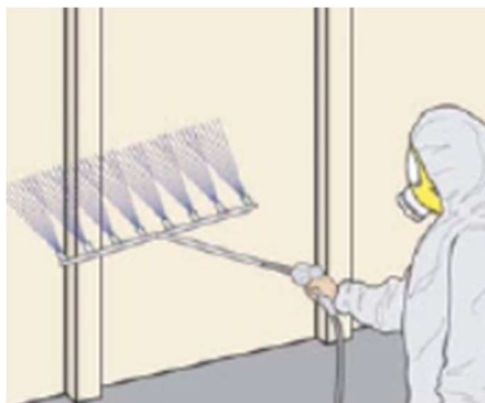
Figuur 2. Doordrenken oppervlak met behulp van een multi-punt spray systeem (HSE, 2012)
