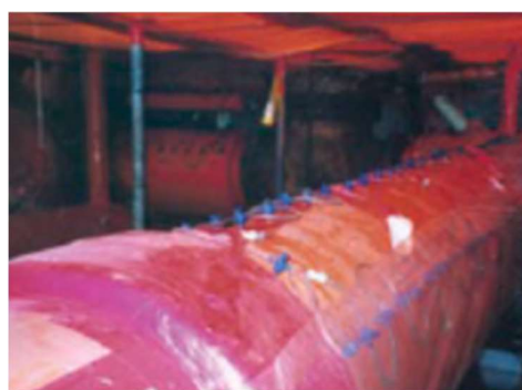
Figuur 3. Doordrenken met behulp van een multi-punt injectie-systeem (HSE, 2012)
