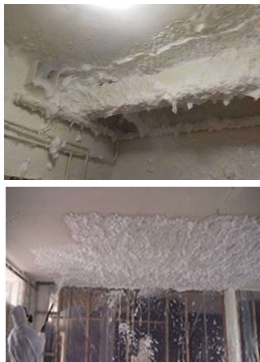
Figuur 1. Voorbeelden van toepassing van schuim op een plafond (foto's beschikbaar gesteld door Nederlandse Arbeidsinspectie (NLA))
