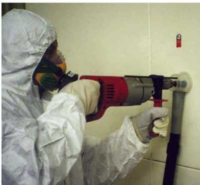
Figuur 4. Stofzuiger bevestigd aan handgereedschap (HSE, 2017)
